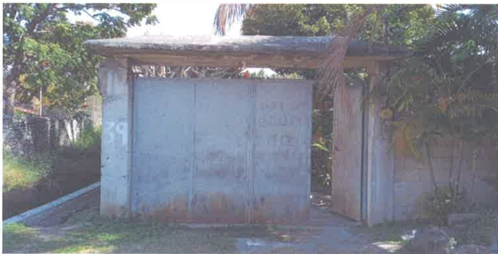
FACHADA DEL INMUEBLE
