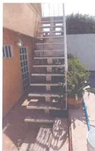
ACCESO SEGUNDO PISO
